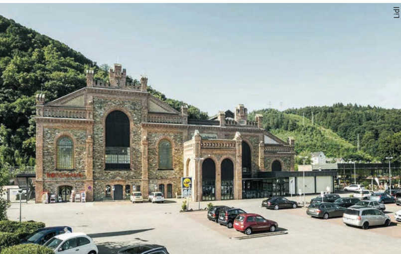
Lidl nutzt für seine Filialen auch historische Gebäude, wie hier vom ehemaligen Emser Blei- & Silberwerk in Bad Ems.
