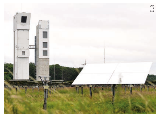
Der DLR-Multifokusturm (rechts) besitzt drei Versuchsebenen und steht neben dem Solarturm Jülich, der bereits 2011 in Betrieb gegangen ist.
