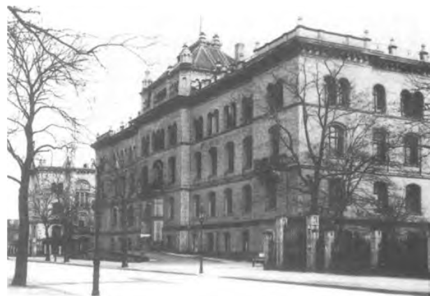
Die von Siemens betriebene Gründung der „Physikalisch-Technischen Reichsanstalt“ in Berlin (1887), deren erster Präsident Helmholtz wurde, brachte neue Themen in die Physikalische Gesellschaft: Das heute noch existierende Gebäude an der Abbestraße.
