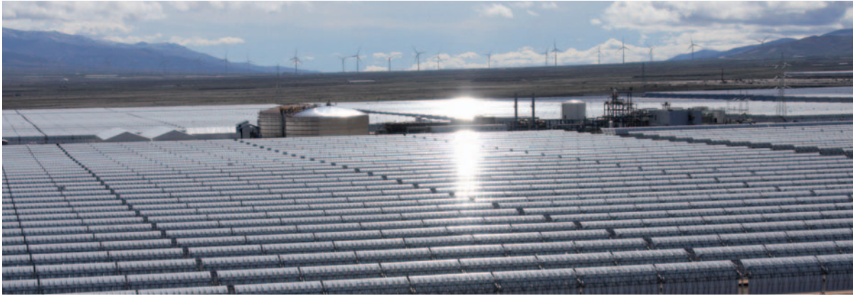
Abb. 4 Unweit Sevilla in Südspanien baut die Solar Millennium AG derzeit drei solarthermische Kraftwerke.
