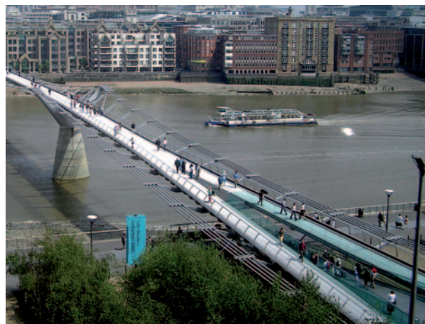
Abb. 1: Die Millenium Bridge in London wurde inzwischen mit Dämpfungselementen ausgestattet, die ein Aufschaukeln verhindern.
