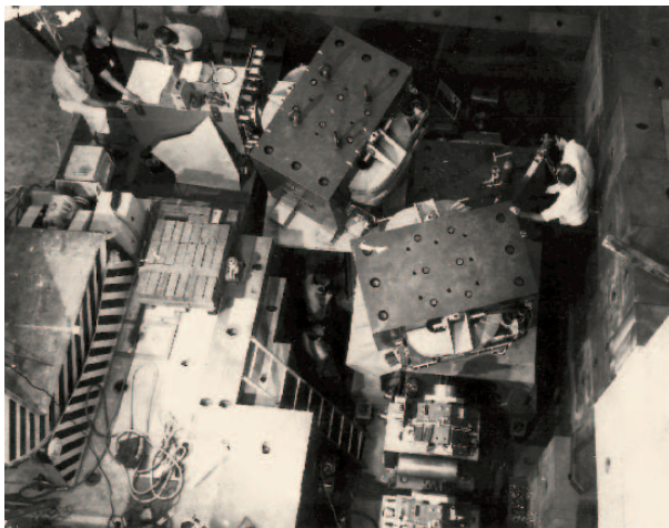
Abb. 2: Der erste niederenergetische K^- -Strahl für die Hyperkernphysik wurde im CERN erzeugt. Um eine Länge des Strahlwegs von nur 10 Meter zu erreichen, wurden Pionen und Kaonen durch ihre unterschiedliche Abbremsung in einem flüssigen Absorber in der Mitte der Strahlführung teilweise separiert.
