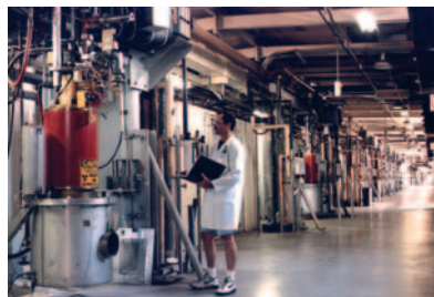
Blick in die „Klystron-Galerie“ am Stanford Linear Accelerator Center. (Foto: SLAC)
