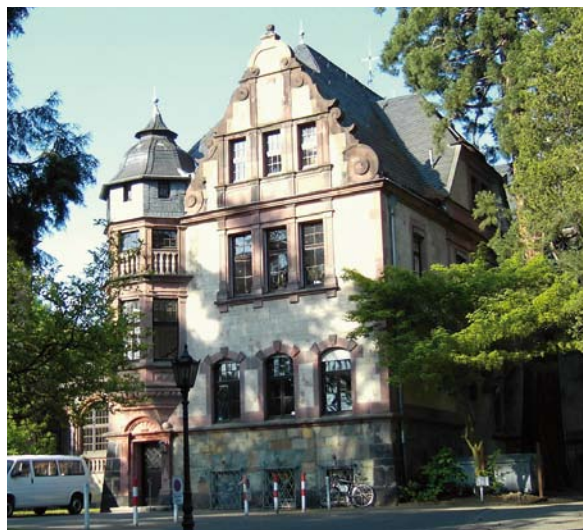
Die Sanierung des Physikzentrums in Bad Honnef soll in Kürze beginnen.
