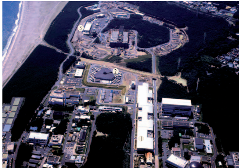
Der japanische Beschleunigerkomplex J-PARC liegt in der Nähe der Küstenstadt Tokaimura. Seine wichtigsten Komponenten sind der Linearbeschleuniger (1)
