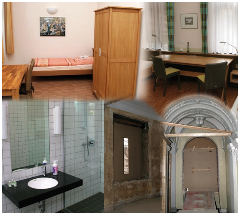
Die Gästezimmer erstrahlen bereits in neuem Glanz und sind nun mit zeitgemäßen Nasszellen ausgestattet. In an-
