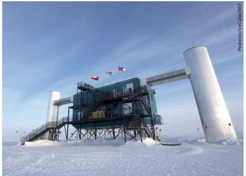
In der IceCube-Oberflächenstation werden die Signale der einzelnen Sensoren gesammelt, weiterverarbeitet und per Satellit an die IceCube-Institute übertragen.
