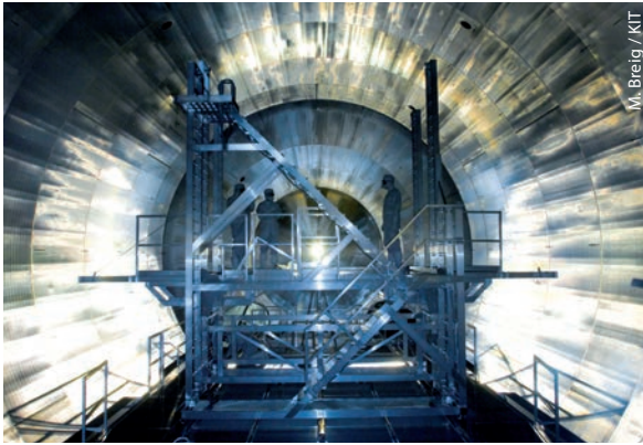
Die Aufbauarbeiten im Hauptspektrometer erfolgten unter Reinraumbedingungen.
